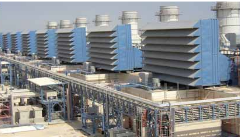
Kraftwerk in Kuwait mit den riesigen Luftansaugsystemen (blau) der Bremer BIS GTS.
